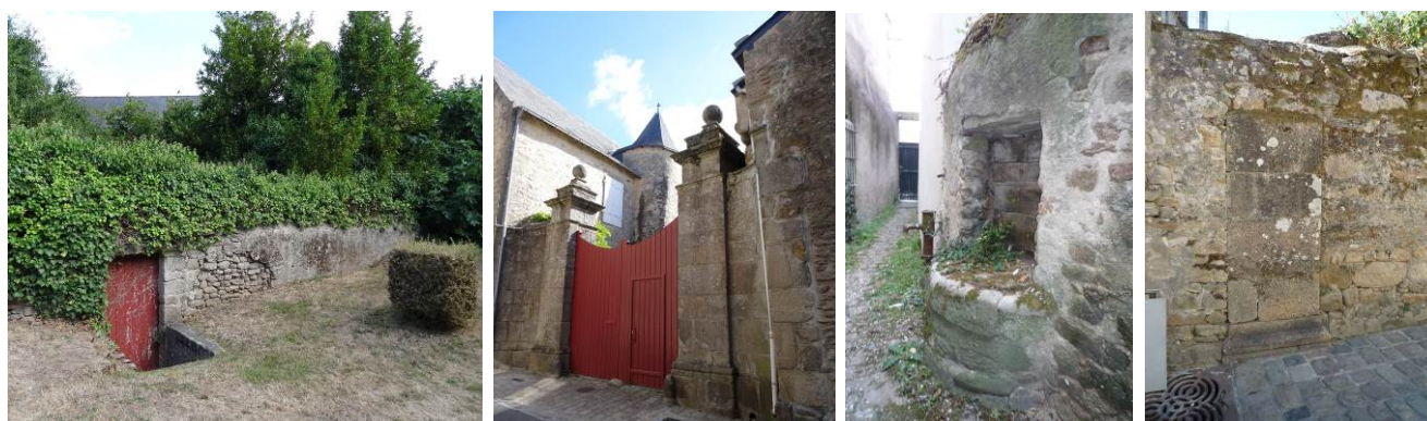
Exemples de clôtures existantes repérées au Plan réglementaire : mur de clôture traditionnel* favorable au développement de la biodiversité ; éléments d'intérêt à conserver : marquage de l'entrée par des piles, puits mitoyen, vestige de pile
