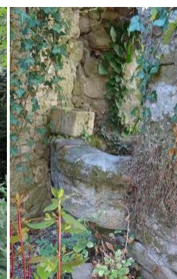
Puits aménagé dans un mur séparatif (rue de Saillé).
