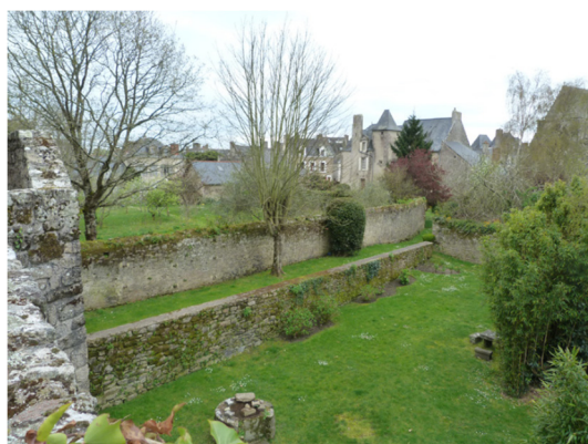
Murs séparatifs servant de soutènement à l'arrière de l'hôtel de la Bouëxière.
