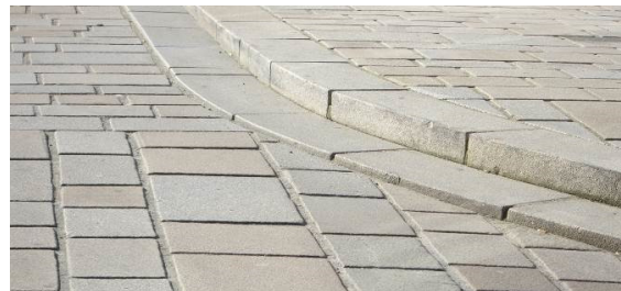
Détails de dallage et pavage granite avec un regard et une grille d'avaloir
