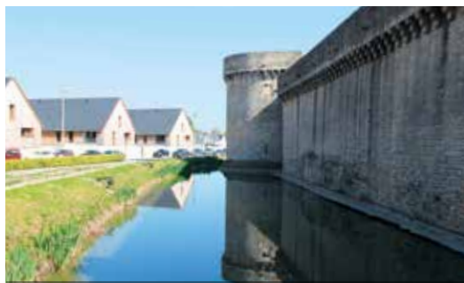
La partie des remparts qui sera rénovée grâce au mécénat
