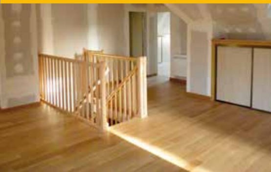
AMÉNAGEMENTS DE COMBLES
